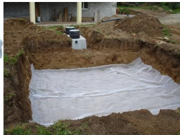
Pour fosse à filtre à sable non drainé : 1 géotextile Geofos et 1 géogrille Grillofos.
