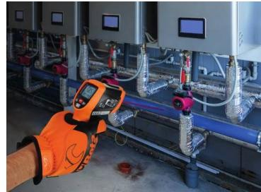
Thermomètre digital à infrarouge avec système de pointage laser double. Ne convient pas pour mesurer la température corporelle.
