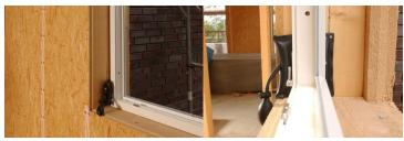
Coussin en plastique renforcé de fibre facilement gonflable à la main. Il permet de positionner et d'ajuster de façon précise les menuiseries et autres objets lourds. Facile d'utilisation. Pose de la fenêtre avec précision. Permet seul de positionner un châssis. Réutilisable et résistant. Ne raye pas les menuiseries.
