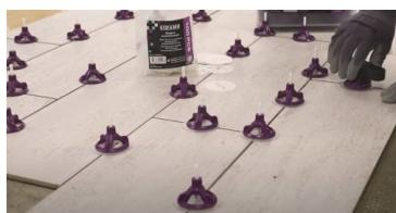
Système auto-nivelant à vis. Pour réaliser un carrelage parfaitement de niveau. Idéal pour les carreaux de grand format.
