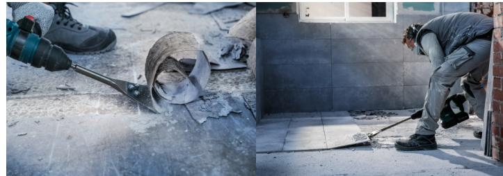
Conçu pour retirer le carrelage. Retrait rapide du carrelage. La large arête de coupe permet un taux d'enlèvement de la matière plus élevé. La lame remplaçable peut être dévissée et retirée de l'emmâchement.
